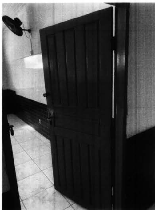
Imagem 6 – Pintura interna e das portas de madeira da escola.
