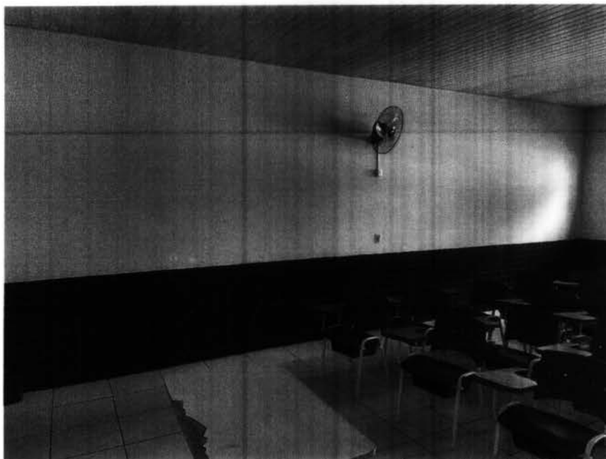
Imagem 3 – Pintura interna da escola e substituição de placas do revestimento 10x10 nas sals de aula.
