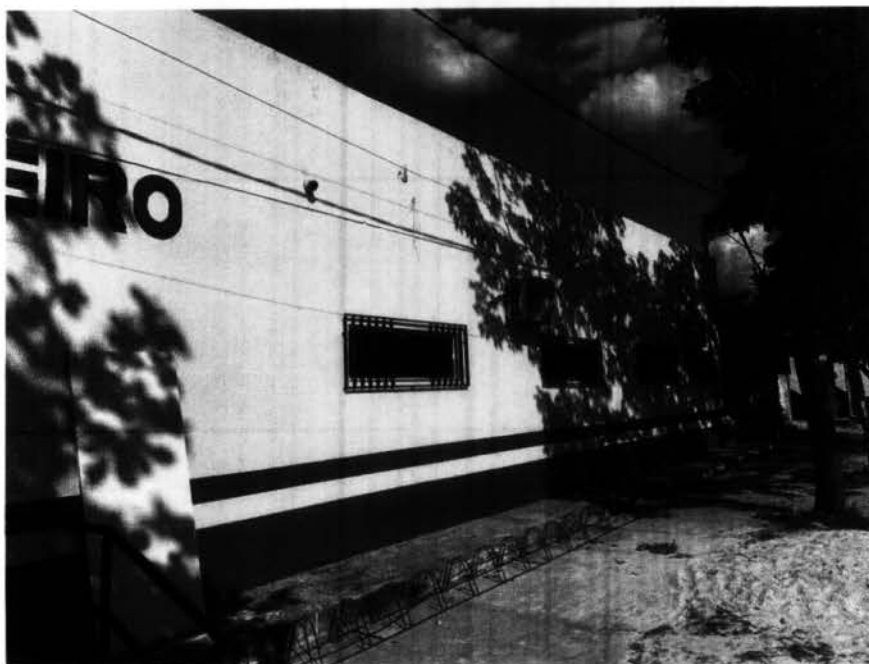
Imagem 1 – Pintura da fachada da escola.
