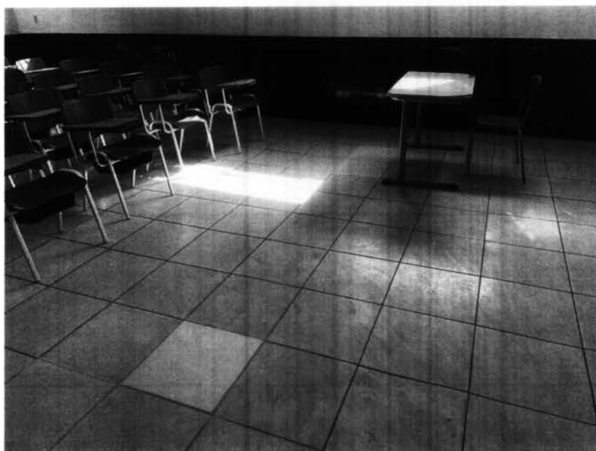
Imagem 8 – Substituição de revestimento cerâmico danificados por novos em pontos das salas de aula.
