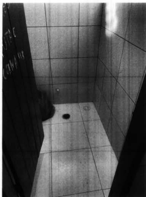
Imagem 9 – Execução do contrapiso e assentamento de revestimento cerâmico nas cabides dos banheiros.
